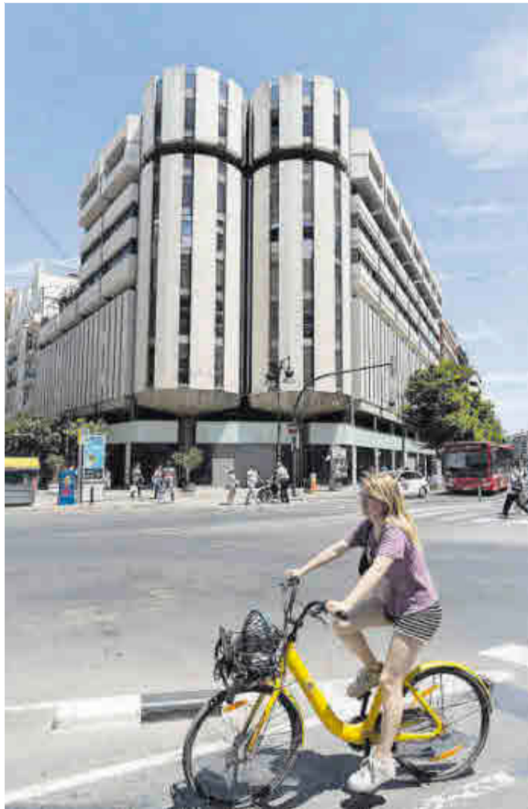
Edificio de la calle Colón que abandona El Corte Inglés. GERMÁN CABALLERO
